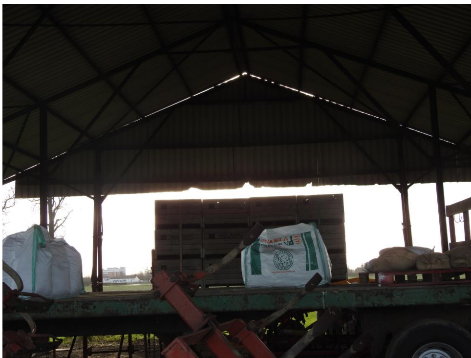
Foto 3. Te slopen hangar binnenzijde.
