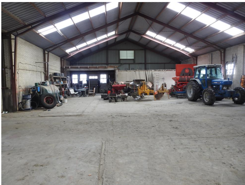
Foto 2. Te slopen schuur binnenzijde.
