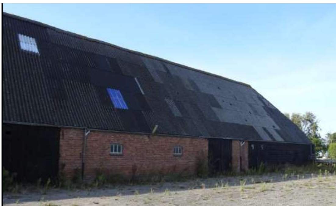
Figuur 2: Te slopen schuur
