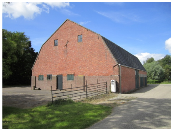
Figuur 2.3 Achtergevel schuur
