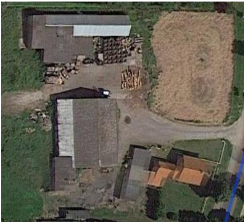
Fig. 3 Plangebied Zwaanstraat 13, Eede bron: streetview (d.d 2017 geraadpleegd en toegevoegd)
