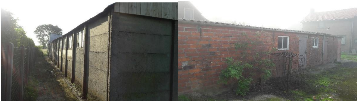
Fig.7 Zijaanzichten van de bestaande oude bedrijfsgebouwen
