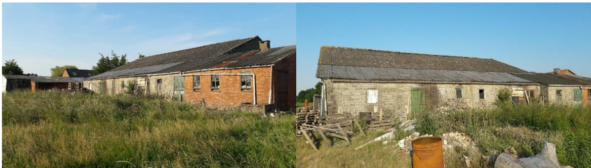
Fig 6. Zijaanzichten van de bestaande oude bedrijfsgebouwen
