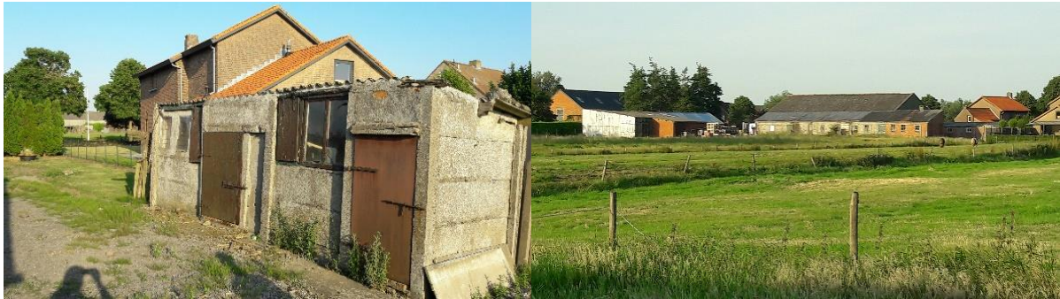
Fig 5. Zijaanzichten van de bestaande oude bedrijfsgebouwen
