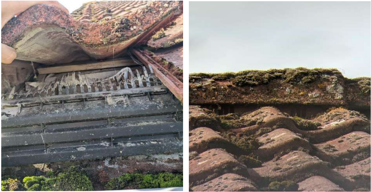
Figuur 1. Links: vogelschoortje onder eerste dakpannenrij. Rechts: Invliegbelemmering onder nokpannen.
