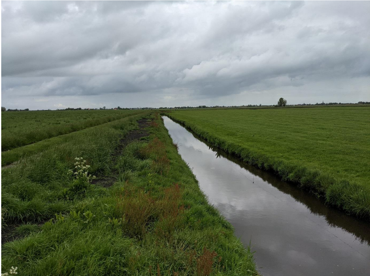
Figuur 9. De sloot t.h.v. de aan te leggen dam in het kader de toegangsweg.
