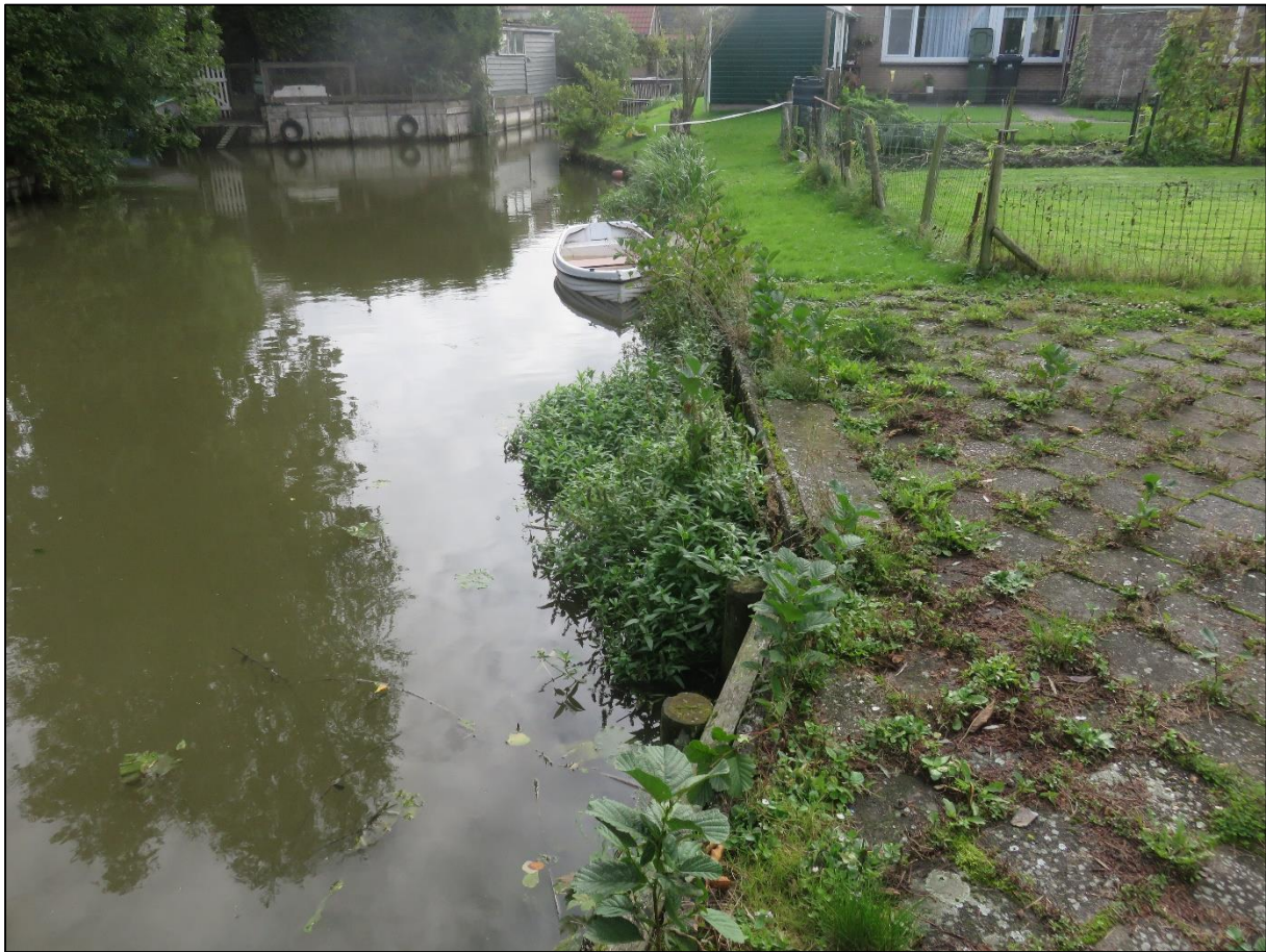
Figuur 2.8. Betegeling rond de loods loopt door tot de waterlijn, waar tevens beschoeiing aanwezig is.
