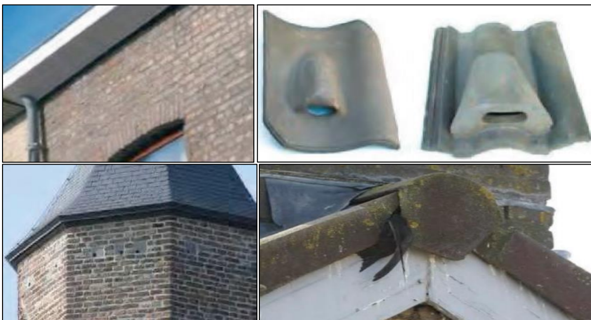
Figuur 4.5. Voorbeelden van hoe nestgelegenheid voor gierzwaluwen gerealiseerd kan worden (bron: Kennisdocument BIJ12). V.l.b.n.ro.: Spleet tussen muur en dakgoot, speciale gierzwaluw dakpannen, geïntegreerde neststenen & overstaande nokpan.
