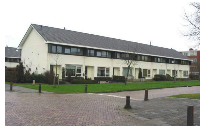
Lemmerweg west na de renovatie
