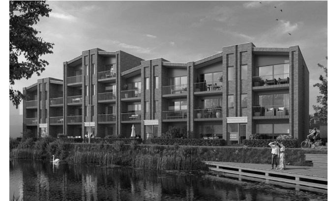
Open naar het zuiden en het water
