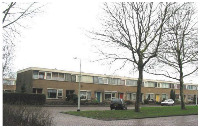
Lemmerweg west voor de renovatie
