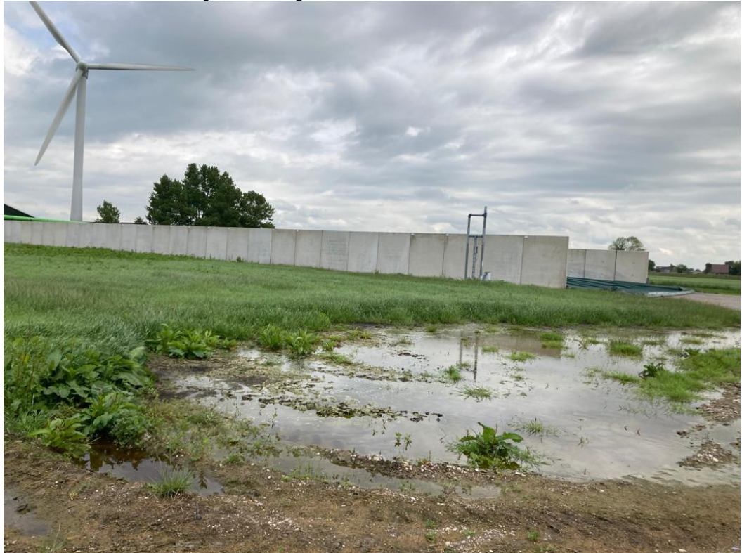
• Afbeelding 14: Te verlengen sleufsilo's
