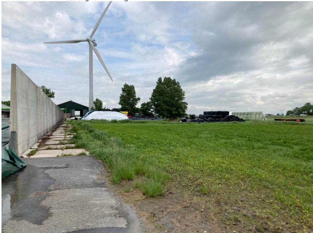
• Afbeelding 15: Te verlengen sleufsilo's
