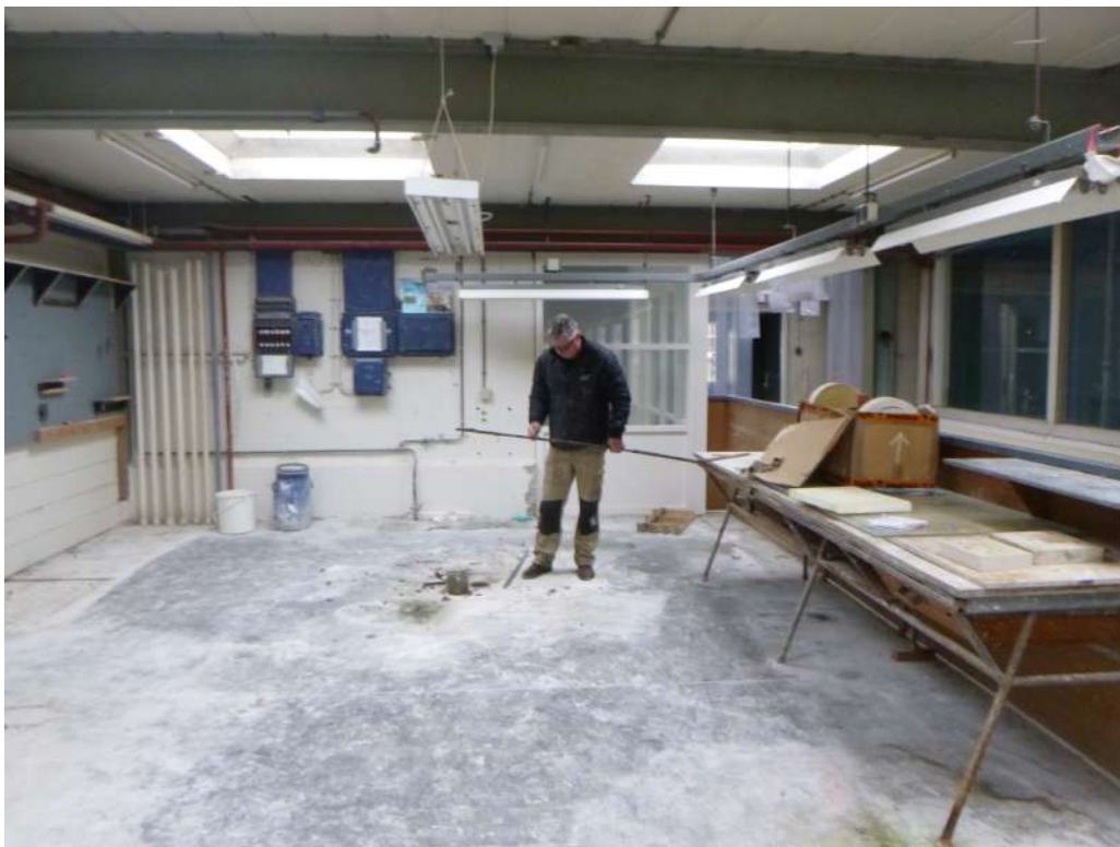
Figuur 7: Makkum, Turfmarkt: Boren door de betonvloer in het voormalige winkelpand.
