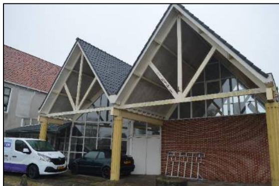
Afbeelding 2.2. Voorzijde voormalige tentoonstellingsruimte, gezien vanaf zuiden.
