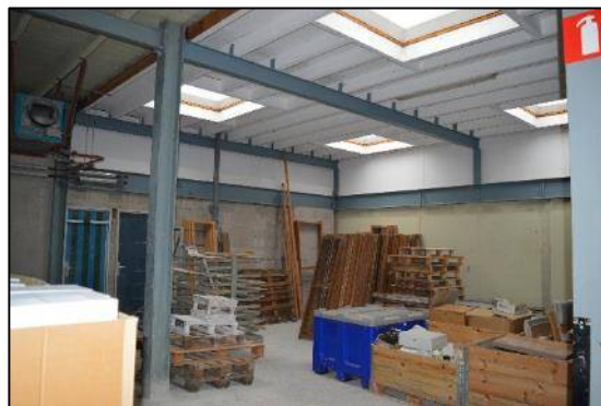
Afbeelding 2.9. Opslag pallets en gipsmallen in de voormalige productieruimte.
