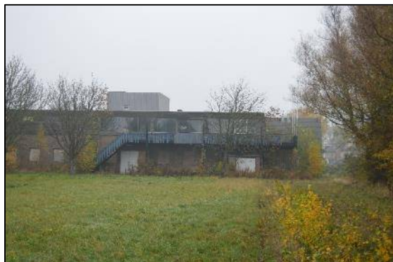
Afbeelding 2.14. Voormalig laboratorium met trap.
