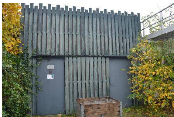
Afbeelding 2.12. Trafo station naast de monumentale panden.
