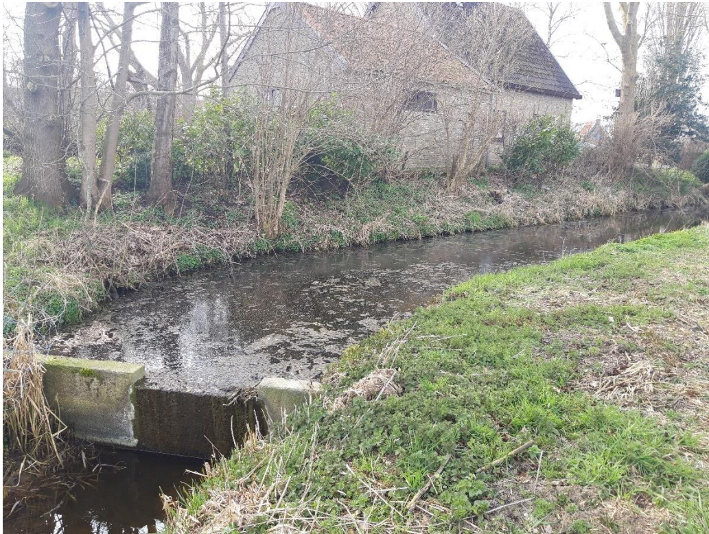
Figuur 2.4: Stuw ten zuidwesten van het plangebied, achter transformator gebouw.
