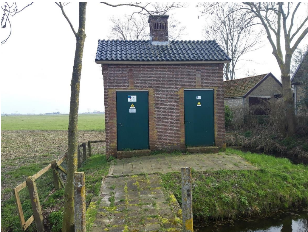
Figuur 2.5: Transformator gebouw ten noordoosten van plangebied.
