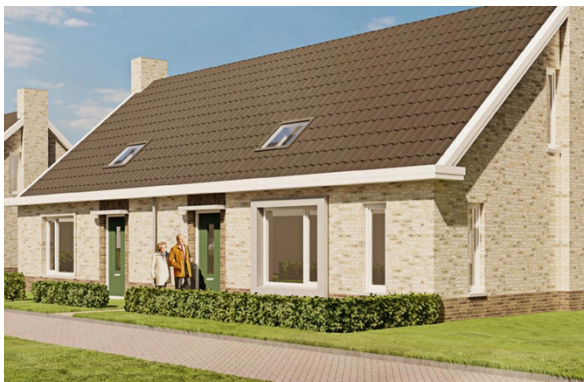
Referentiebeeld detaillering: vriendelijke uitstraling door dakoverstek, trasraam, verbijzonderingen in het metselwerk, dakramen (knarrenhof Emmen).
