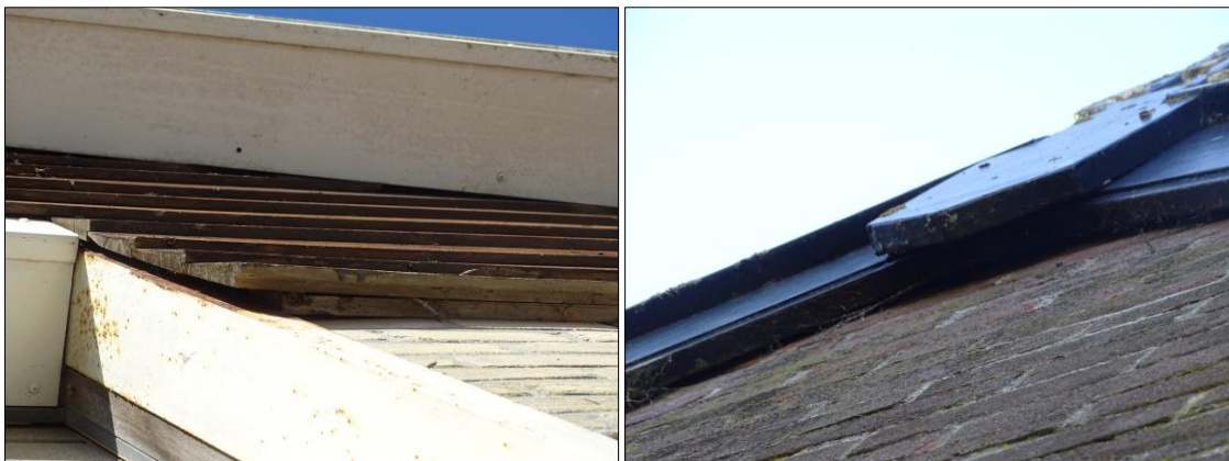
Foto's 7 en 8. Links de gevelbetimmering aan de zuidoostelijke kopse kant van de middelste loods (nummer 4). Rechts de boeiboorden aan de noordelijke kopse kant van de zuidelijke loods (nummer 5)
