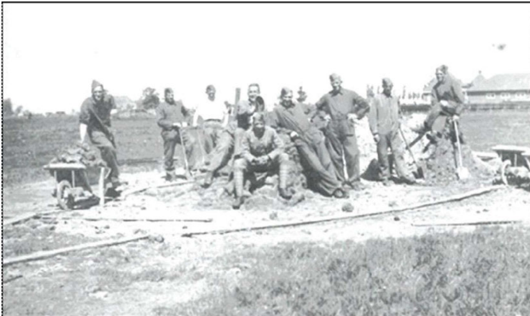
Figuur 10: Makkum, Simmerfjild: Soldaten bezig met de bouwwerkzaamheden voor een kazemat (Topper 2010, 51).
