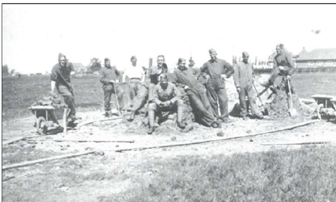
Fig. 2 Soldaten bezig met de bouwwerkzaamheden voor een kazemat (Bron: Topper 2010, 51).
