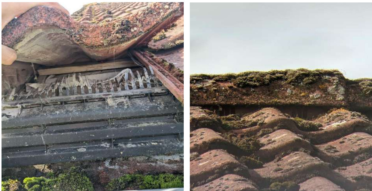
Figuur 5. Links: vogelschoortje onder eerste dakpannenrij. Rechts: Invliegbelemmering onder nokpannen.
