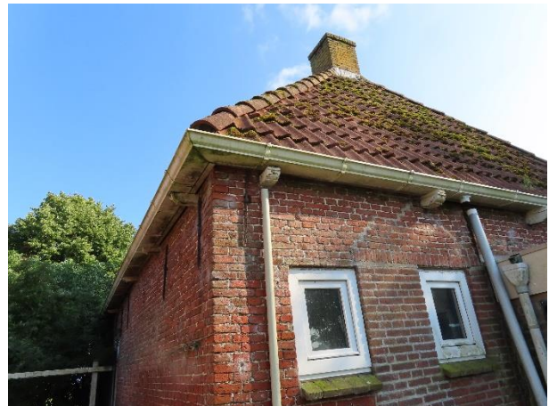
Figuur 3: Aanzicht zijgevelwoning
