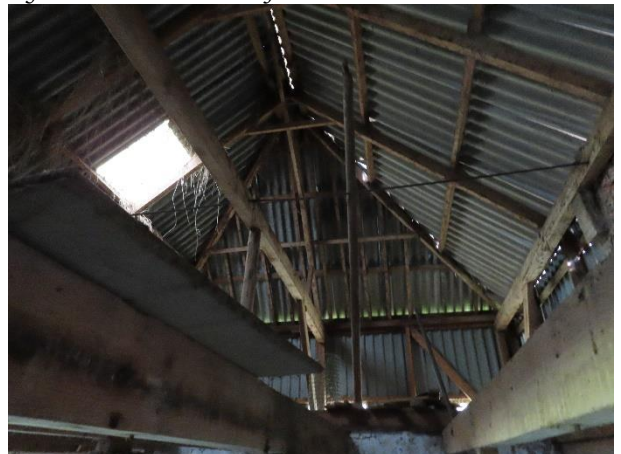
Figuur 10: Aanzicht binnenzijde schuur
