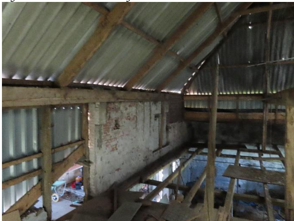
Figuur 9: Aanzicht binnenzijde schuur
