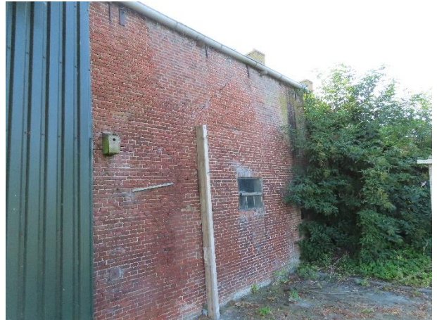
Figuur 8: Aanzicht achterzijde schuur
