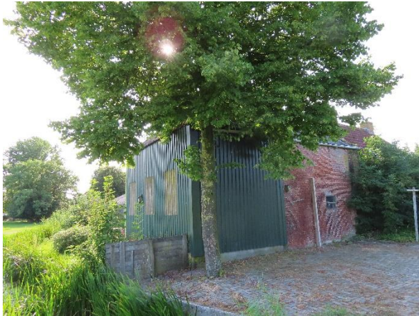
Figuur 7: Aanzicht achterzijde schuur
