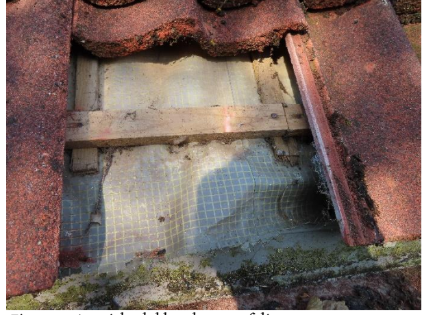
Figuur 5: Aanzicht dakbeschot met folie
