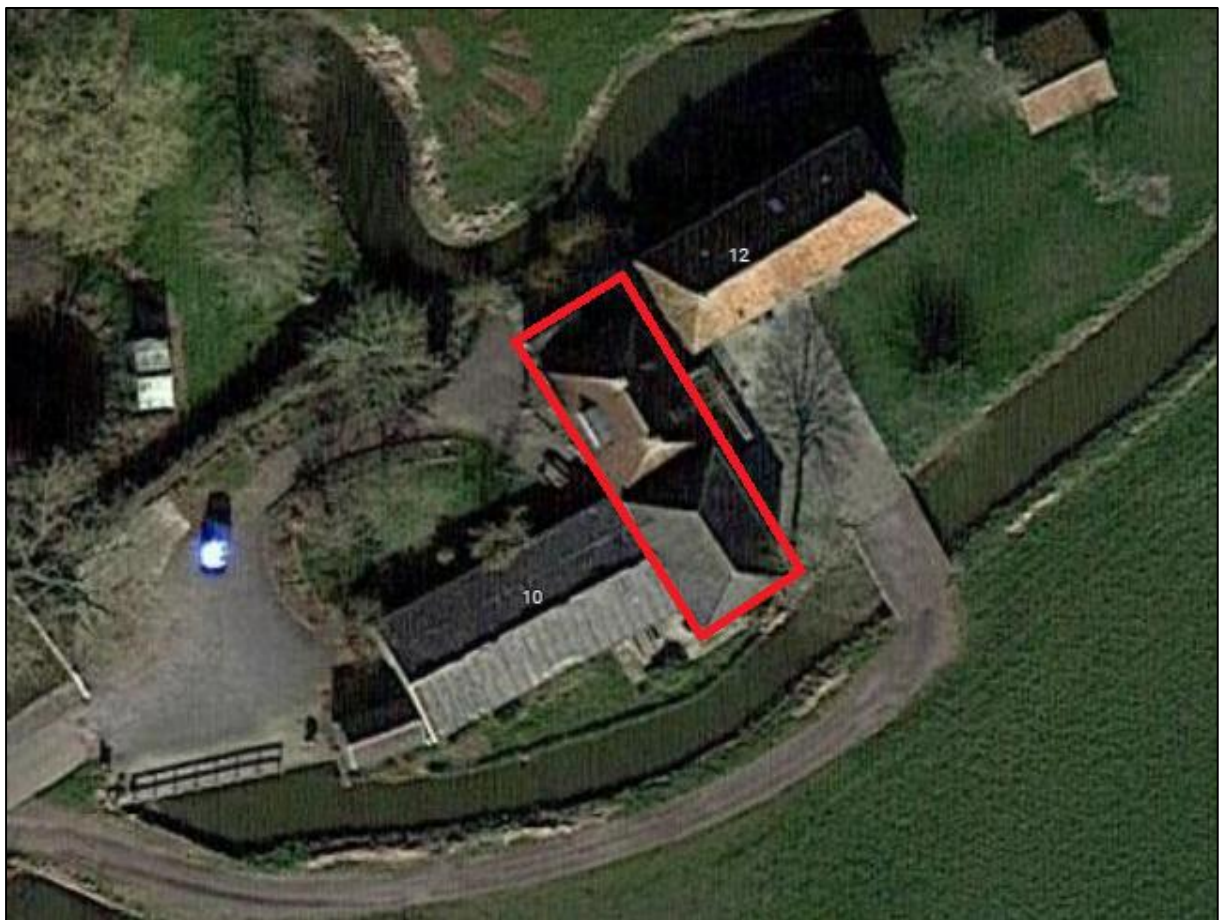
Figuur 2.2.: In het plangebied is bebouwing aanwezig waarin vleermuizen kunnen verblijven (rood omlijnd).
