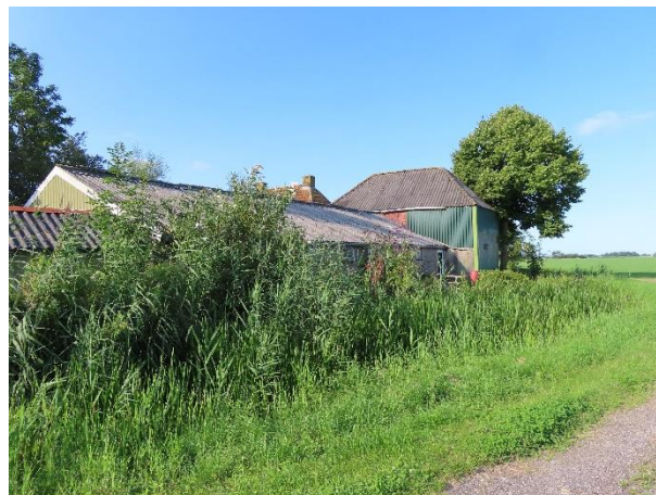
Figuur 12: Aanzicht zijgevel stal en naast gelegen sloot
