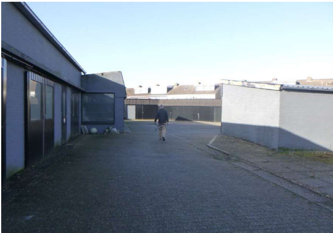
Figuur 9: IJlst, Holtropweg 3 & 5: Foto van het plangebied vanuit het oosten, in westelijke richting.
