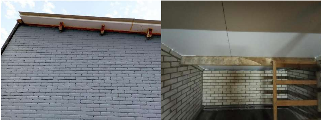
Figuur 4.1 Met pur gedichte openingen ter plaatse van de showroom met achterliggende garage.
