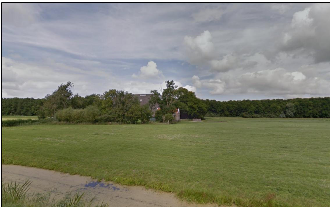
Figuur 3. Achterzijde woonboerderij Tsjaerddyk 1 te Nijland.
