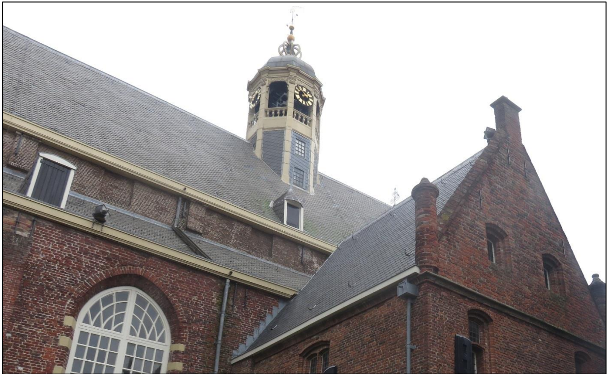
Figuur 2.2. Plat pannendak van het de toekomstige jongerenvoorziening met afgesloten nok.
