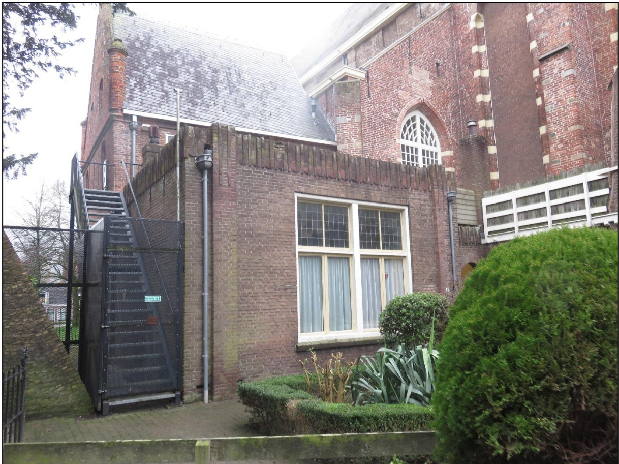
Figuur 2.3. Grote Kerkstraat 9 beschikt over een plat dak.
