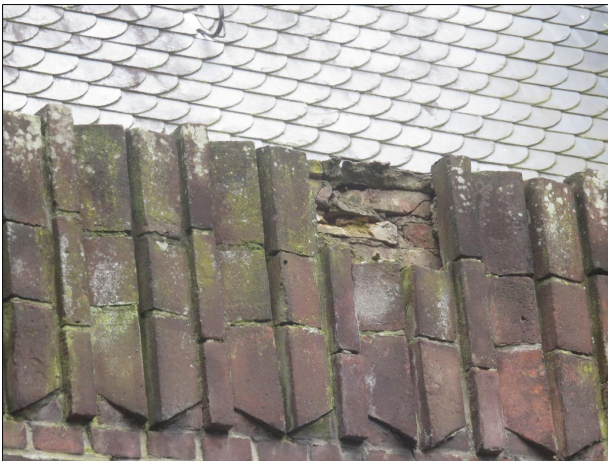
Figuur 2.7. Blootliggende poreuze laag aan de bovenzijde van Grote Kerkstraat 9.
