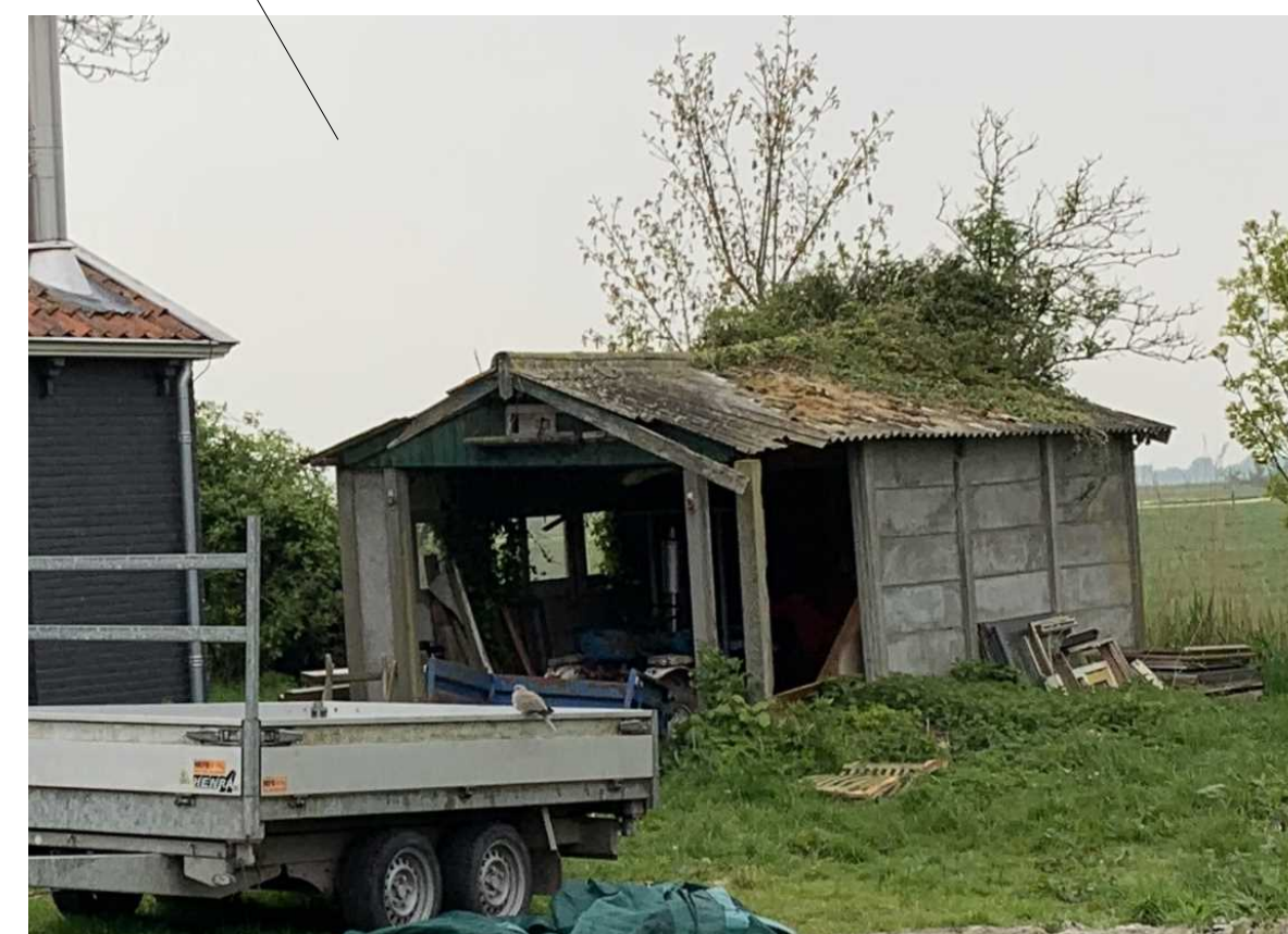
voormalige garage bij 2e bedrijfswoning
