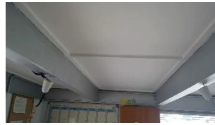
Foto voor bron Plafondbeplating (Plafondbeplating 05)
