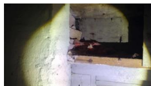
Foto voor bron Wandbeplating (Wandbeplating 02)
