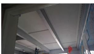
Foto voor bron Plafondbeplating (Plafondbeplating 05)
