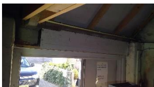
Foto voor bron Wandbeplating (Wandbeplating 02)
