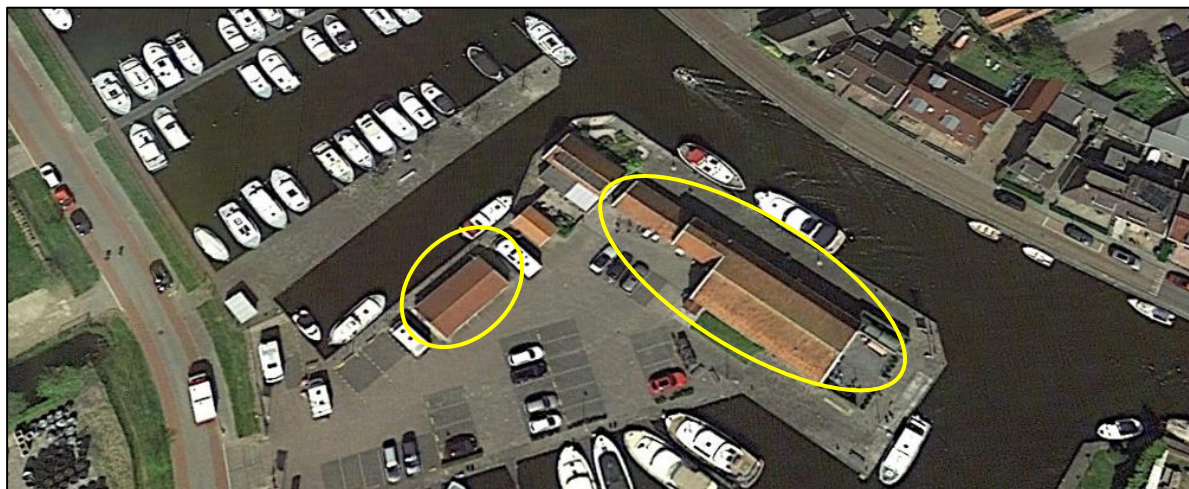
Afb 2: De te slopen panden gelegen aan de Selfhelpweg 7 in Sneek
