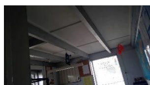
Foto voor bron Plafondbeplating (Plafondbeplating 05)
