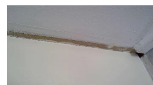
Foto voor bron Plafondbeplating (Plafondbeplating 05)
