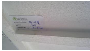
Foto voor bron Plafondbeplating (Plafondbeplating 05)
