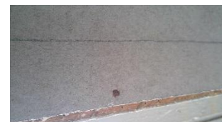
Foto voor bron Wandbeplating (Wandbeplating 02)
