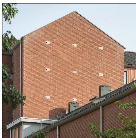
Afb 12 + 13: Mussenkasten ingemetseld (worden ook gebruikt door Gierzwaluwen)
