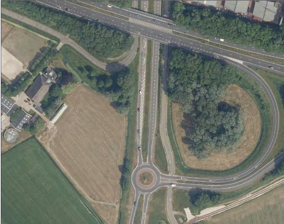
Figuur 2.1 Luchtfoto huidige situatie
