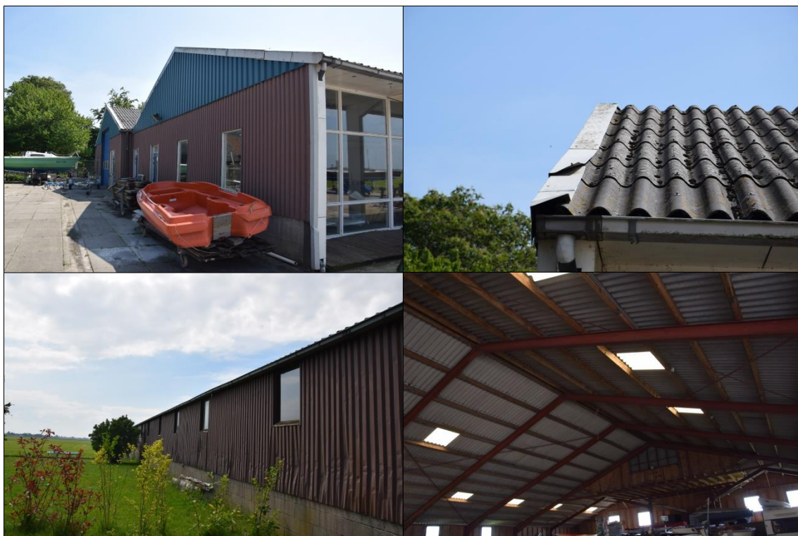
Foto's 3-6. Linksboven de oostzijde van de loods, gezien vanuit het noorden. Rechtsboven het dak aan de noordoostzijde van de loods. Linksonder het zicht op de zuidzijde van de loods. Rechtsonder de binnenzijde van de loods.
