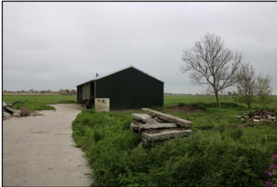
Afbeelding 2.2. Te slopen kapschuur en puin.
