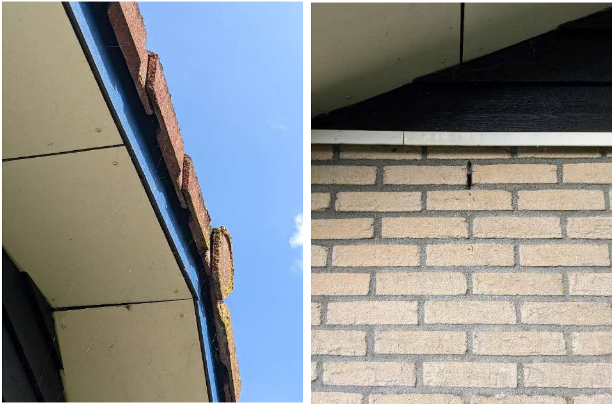
Figuur 4. Links: Invliegopeningen onder hoekpannen. Rechts: te smalle stootvoegen voor invliegen vleermuizen.
