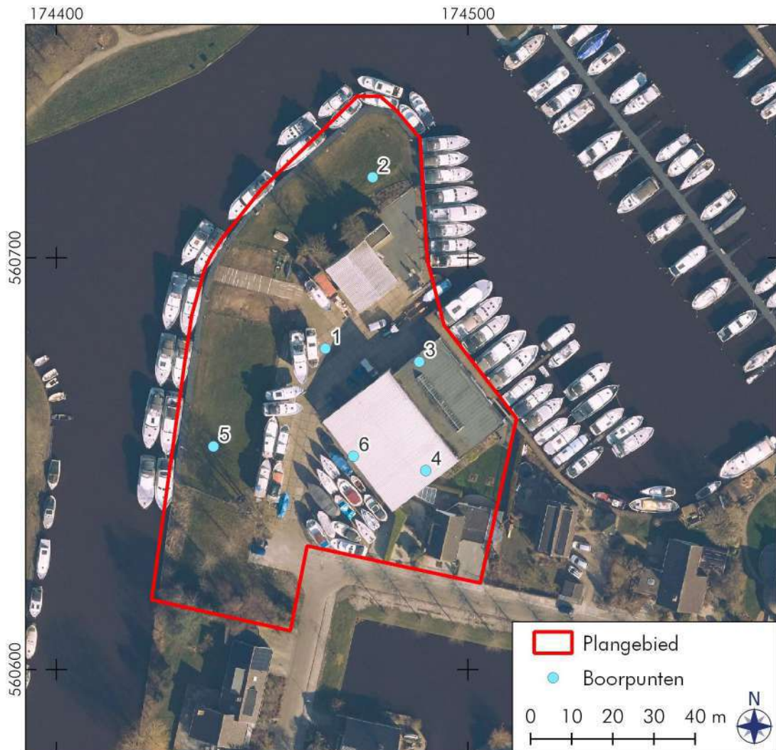
Figuur 8: Sneek, Zoutepoel 4: Locatie van de boringen. Omdat de loodsen al waren gesloopt konden de boringen ook op de locaties van de de loods worden geplaatst. Vanwege de aanwezige kabels en leidingen in het zuidelijk deel van het plangebied (zie Figuur 2) zijn hier geen boringen gezet.
