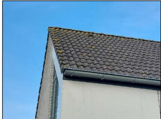
Afbeelding 2.15. Dakpannen dak en dakgoot van de woning.
