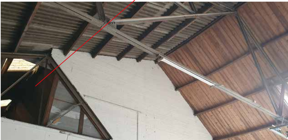
Figuur 5. Binnenzijde: impressie van de dakdelen met links de zoldering.
