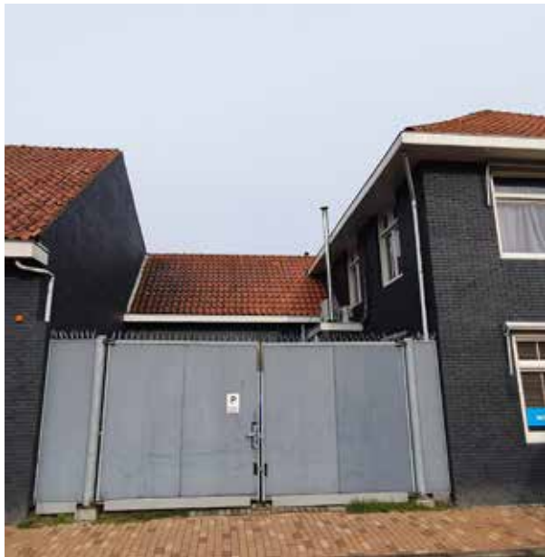
Figuur 3. Het verbindingsdeel tussen het pakhuis en kantoor.
