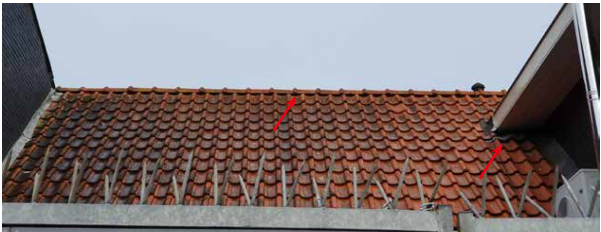
Figuur 11. Potentiële invliegopeningen vleermuizen (en huismussen).
