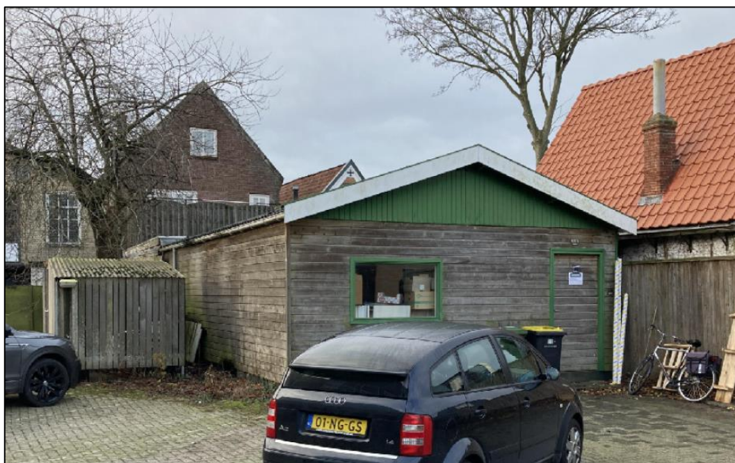
Figuur 4.1 Te slopen aanbouw
