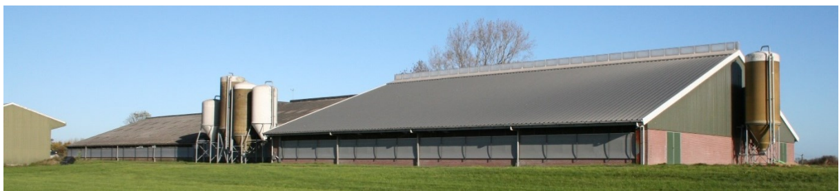
Figuur 3. Bestaande toestand, kop-rompboerderij op terp met melkcarrousel, verlengde melkveestal, kapschuur
