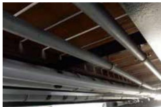
Afbeelding 3: nutsleidingen zijn geïntegreerd in de steigers in aansluiting op de oever.
