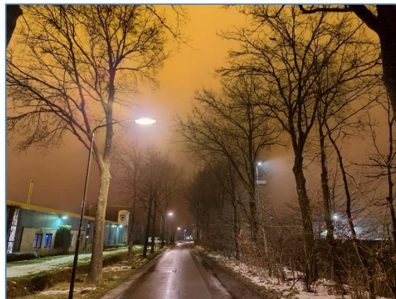
De verhoogde lichtmast aan de rechterzijde en straatverlichting aan de linkerzijde. Zie het verschil in uitstraling. De lichtmast heeft een sterke gebundelde uitstraling en de straatverlichting heeft veel verstrooiing.
