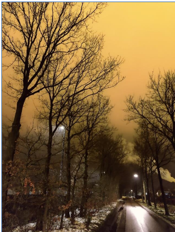
De verhoogde lichtmast aan de linkerzijde en straatverlichting aan de rechterzijde
