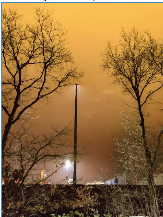
De verhoogde lichtmast. Hierbij is prima te zien dat de uitstraling zeer beperkt en sterk gericht is.
