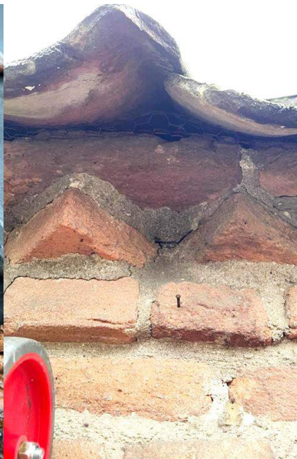
De overhangende kantpannen en overige openingen zijn afgedicht met o.a. gaas
