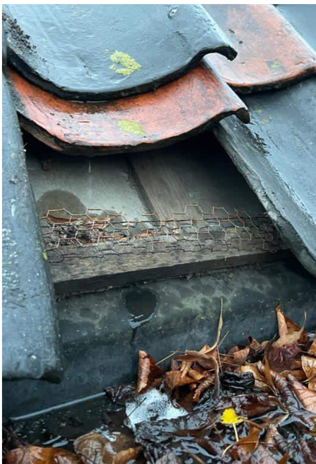
De overhangende kantpannen en overige openingen zijn afgedicht met o.a. gaas
