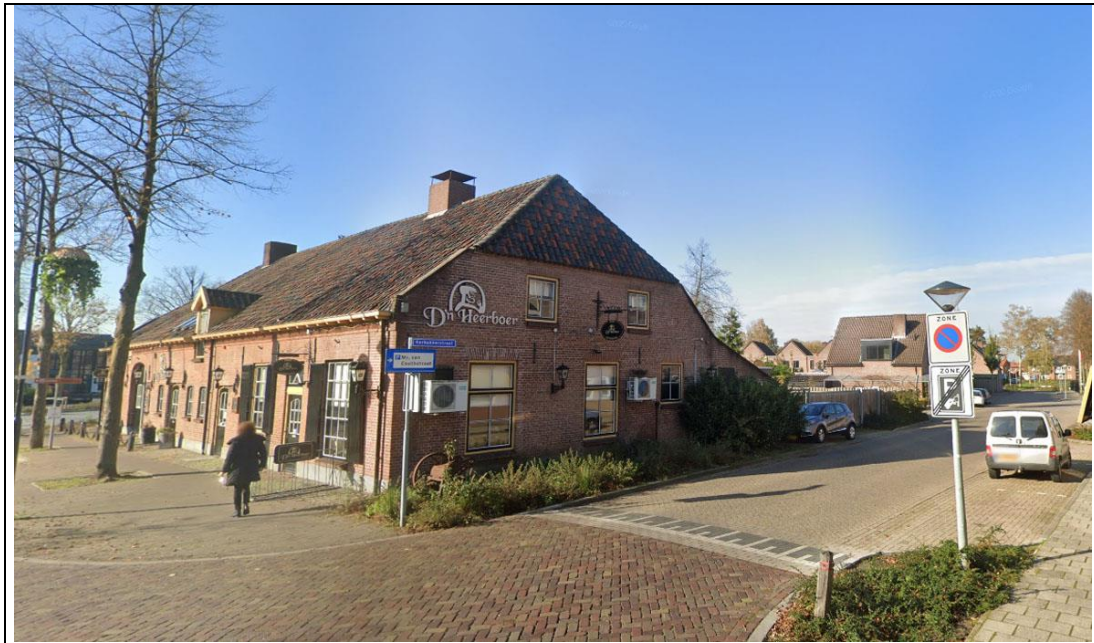
Afbeelding 5: Gevelaanzicht bestaande pand.
