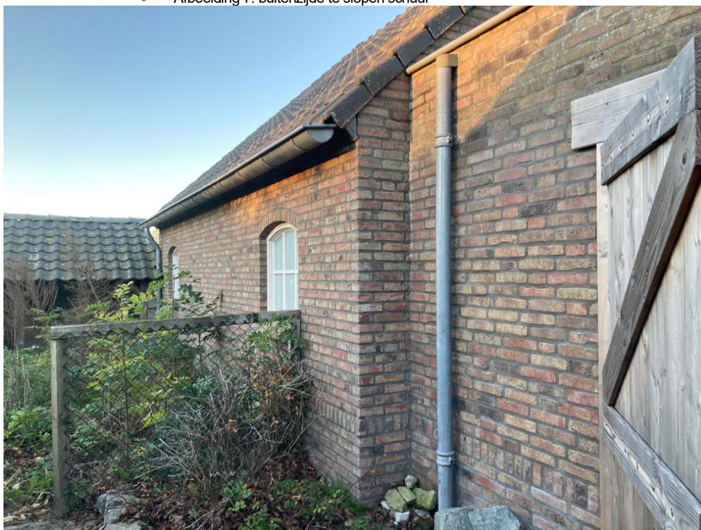
• Afbeelding 7: buitenzijde te slopen schuur
