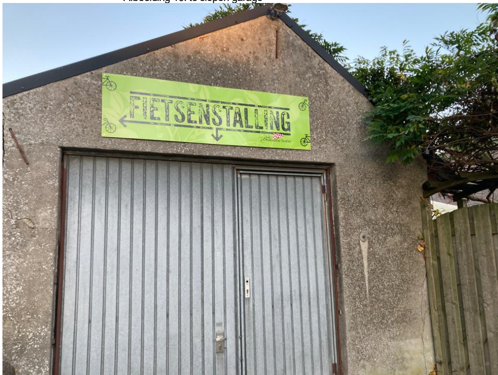
• Afbeelding 10: te slopen garage
