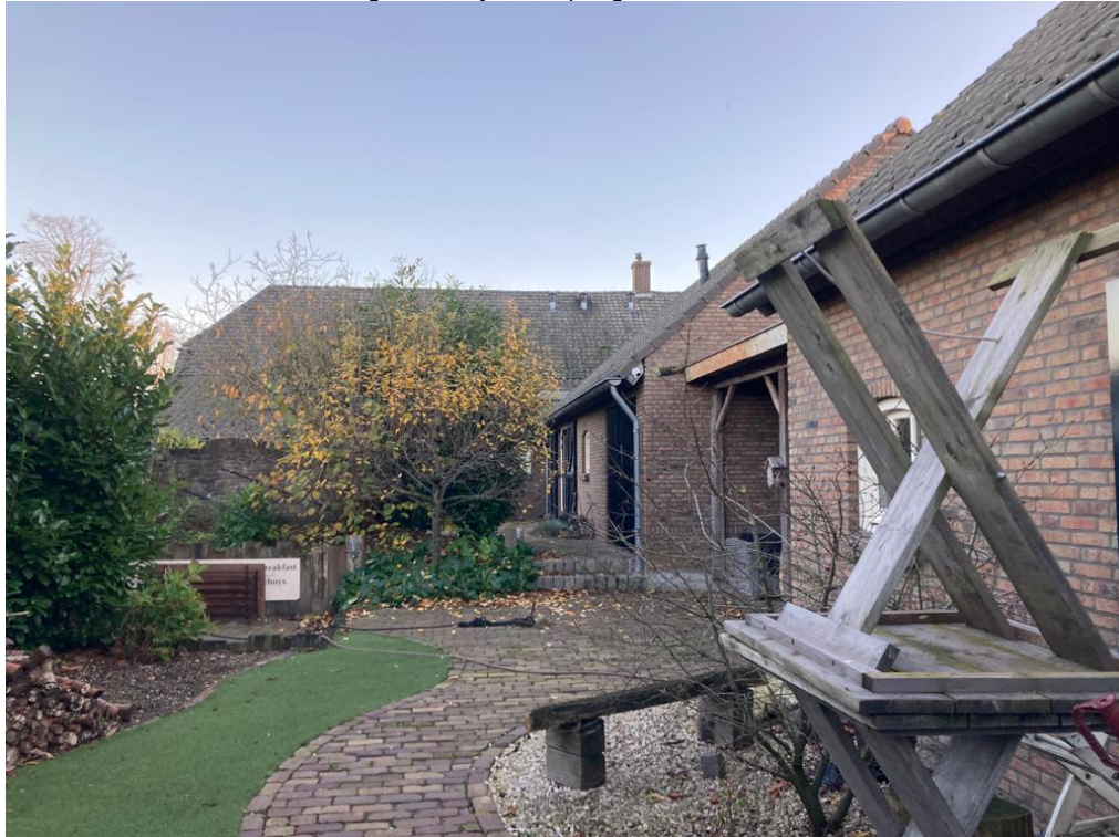
• Afbeelding 18: voorzijde te slopen gebouw
