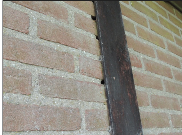
Figuur 17. Geschikte spouwmuur openingen achter ijzer plaat van de voormalige varkensstal.
