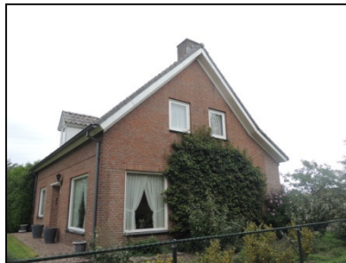
Figuur 4. Noordwestzijde woonhuis.
