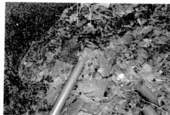
Foto 4: Stukken asbestcement golfplaat
