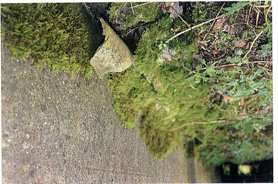
Foto 5: Stukken asbestcement golfplaat
