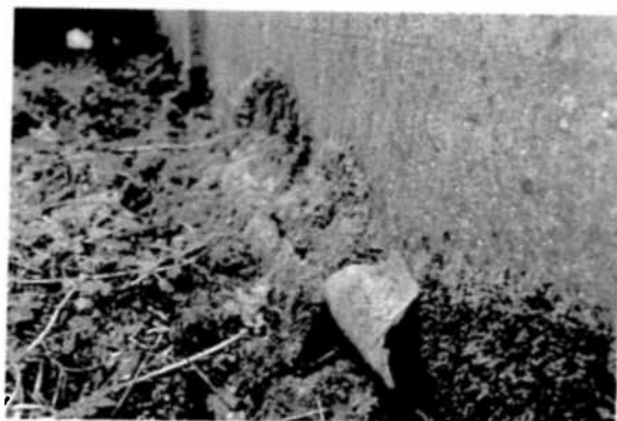
Foto 5: Stukken asbestcement golfplaat
