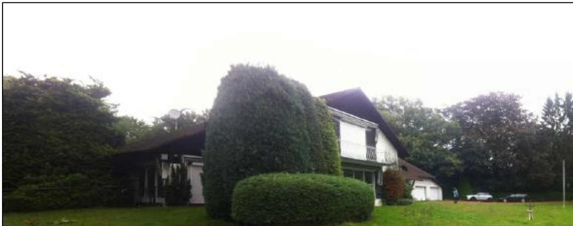
Foto aanzicht voormalige woning binnen plangebied
