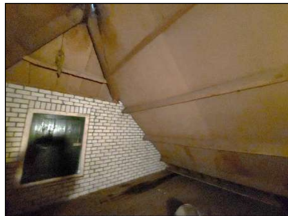
Figuur 19. Zolder van de bebouwing.
