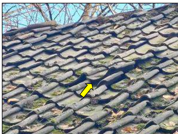
Figuur 14. Ruimtes onder de dakpannen.
