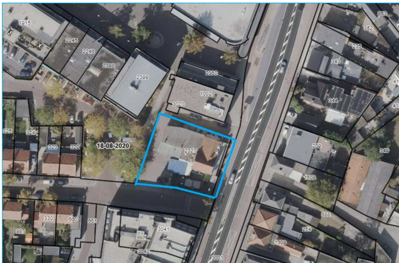
Afbeelding: Bovenaanzicht projectlocatie Eindhovenseweg 29
