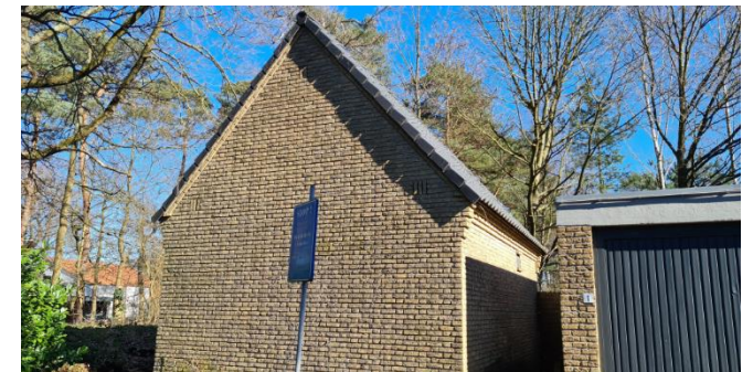
Figuur 6: Elektriciteitsgebouw ten noorden van garageboxen
