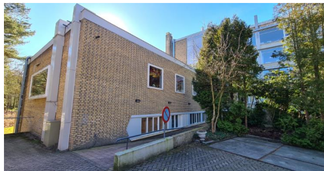
Figuur 5: Zijde aanbouw nieuwe vleugel
