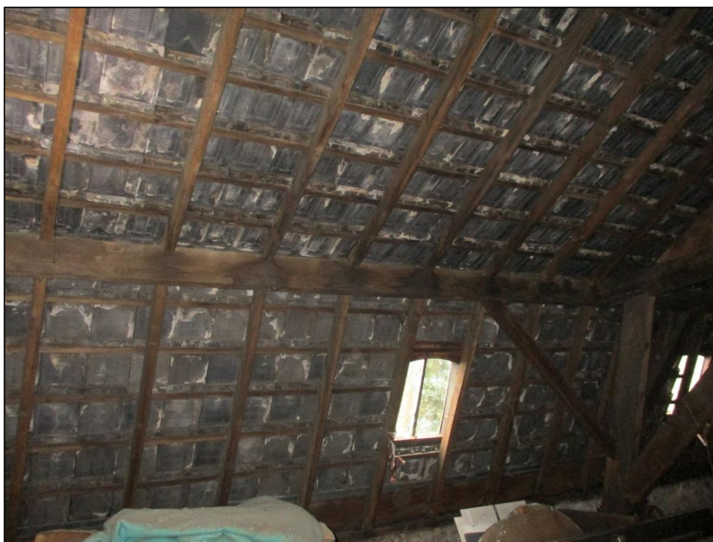
Figuur 2 Binnenzijde van de schuur.
