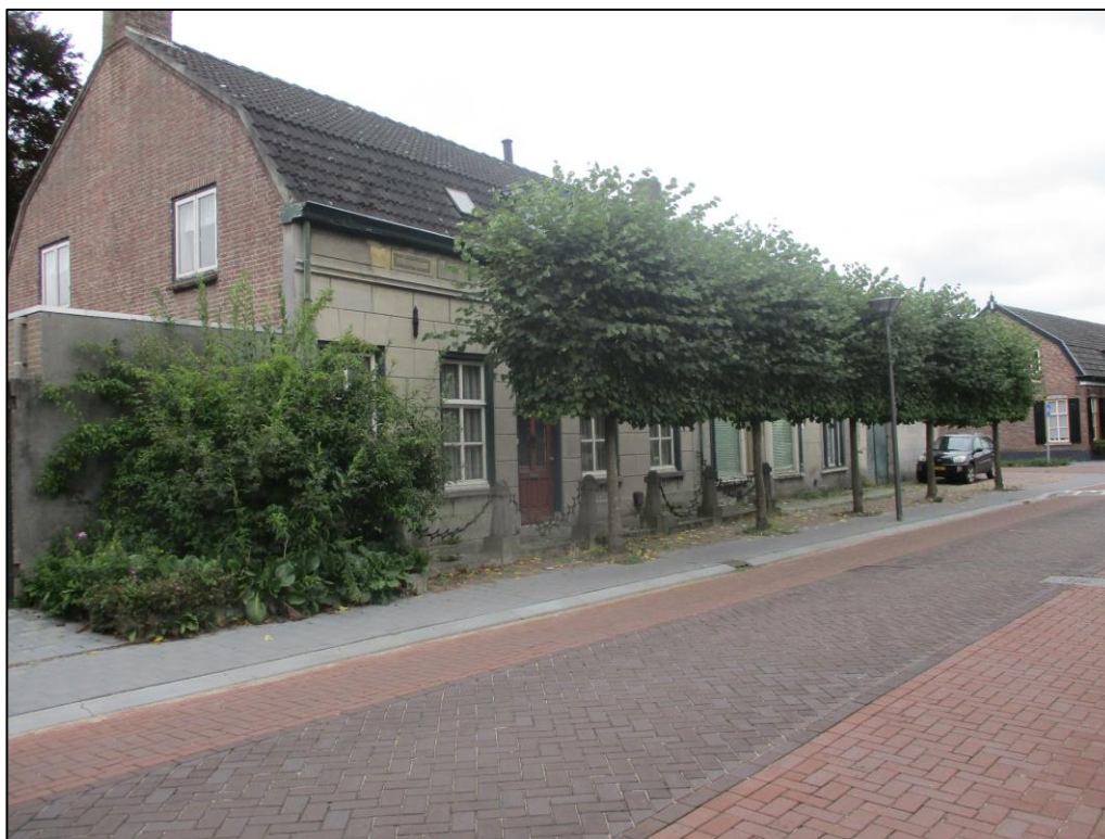
Figuur 1 Het monumentale pand.
