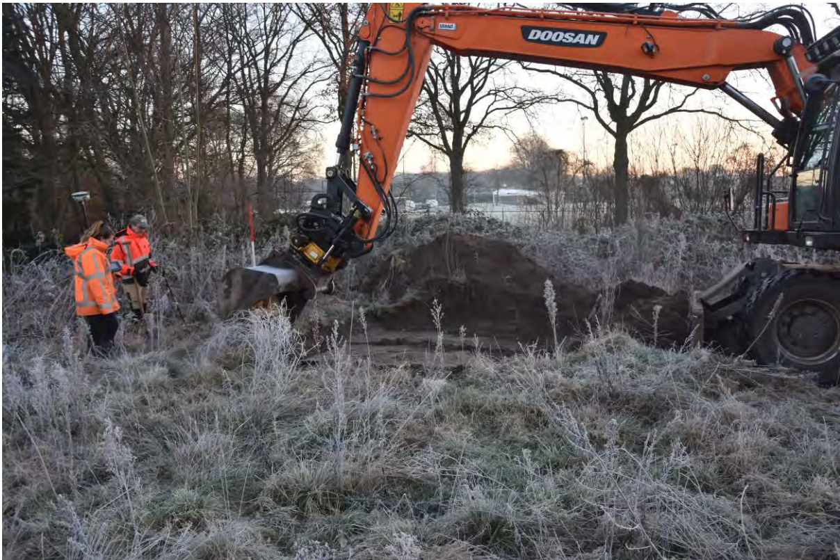
Fig. 1.4. Aalst-Brabantia. Werkzaamheden bij de aanleg van proefsleuf 1.
