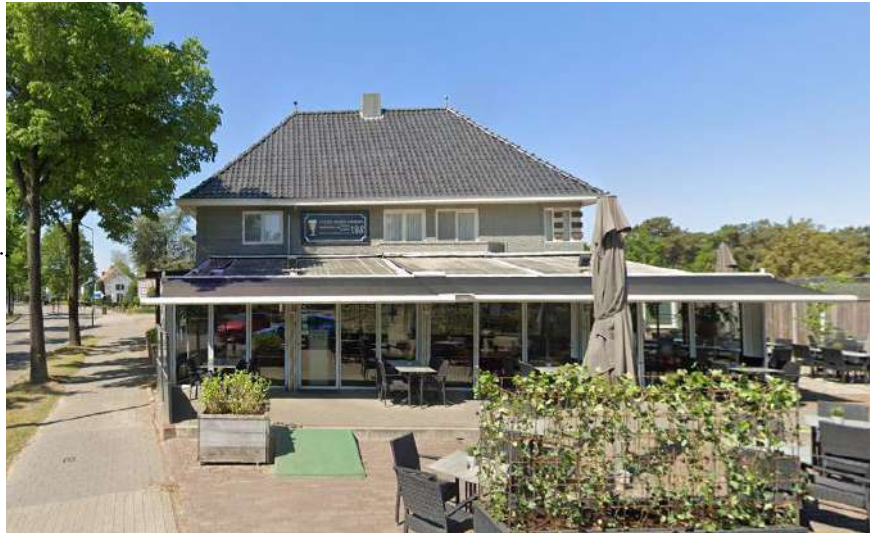
Belendende bebouwing t' Stationskoffiehuis
