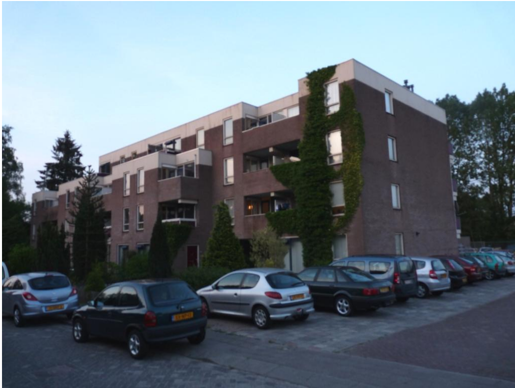
Foto 7. Het te slopen appartementencomplex aan de Eindhovenseweg.
