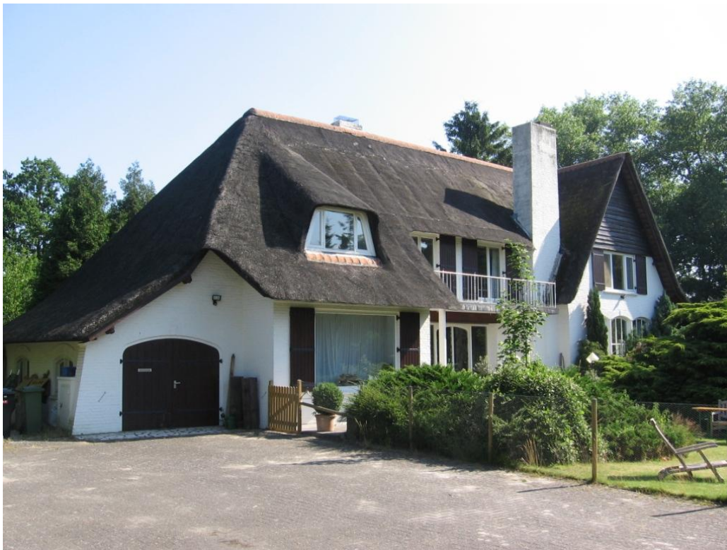
Foto 8. Het te slopen woonhuis nummer 5 aan de Brabantiaalaan.
