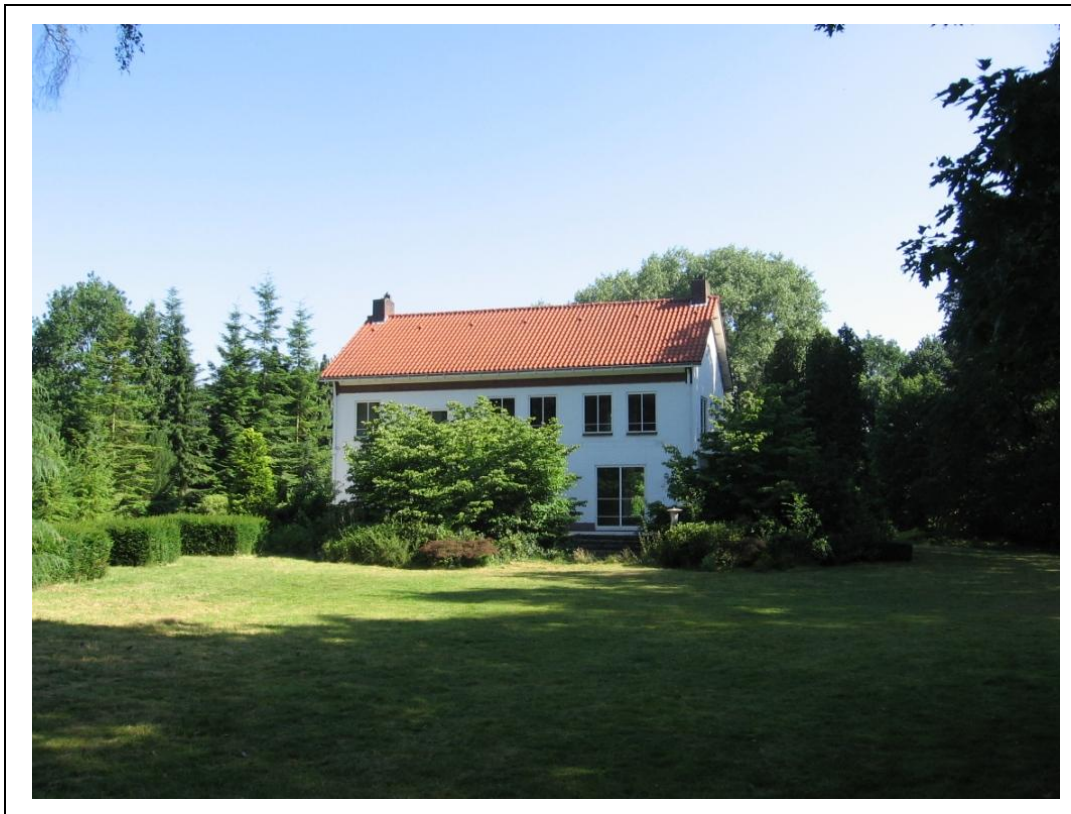
Foto 9. Het te slopen woonhuis nummer 7 aan de Brabantiaalaan.
