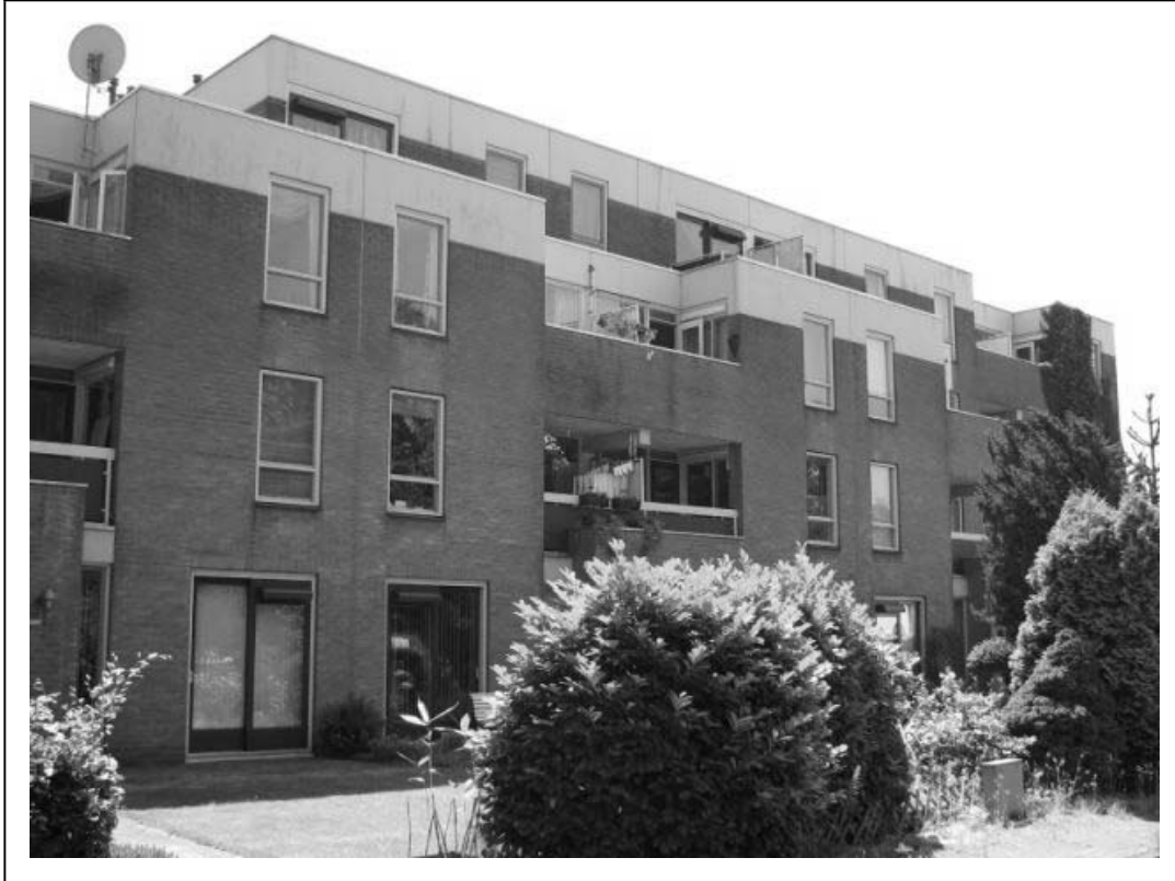
Foto 9. Het appartementencomplex aan de Eindhovenseweg.
