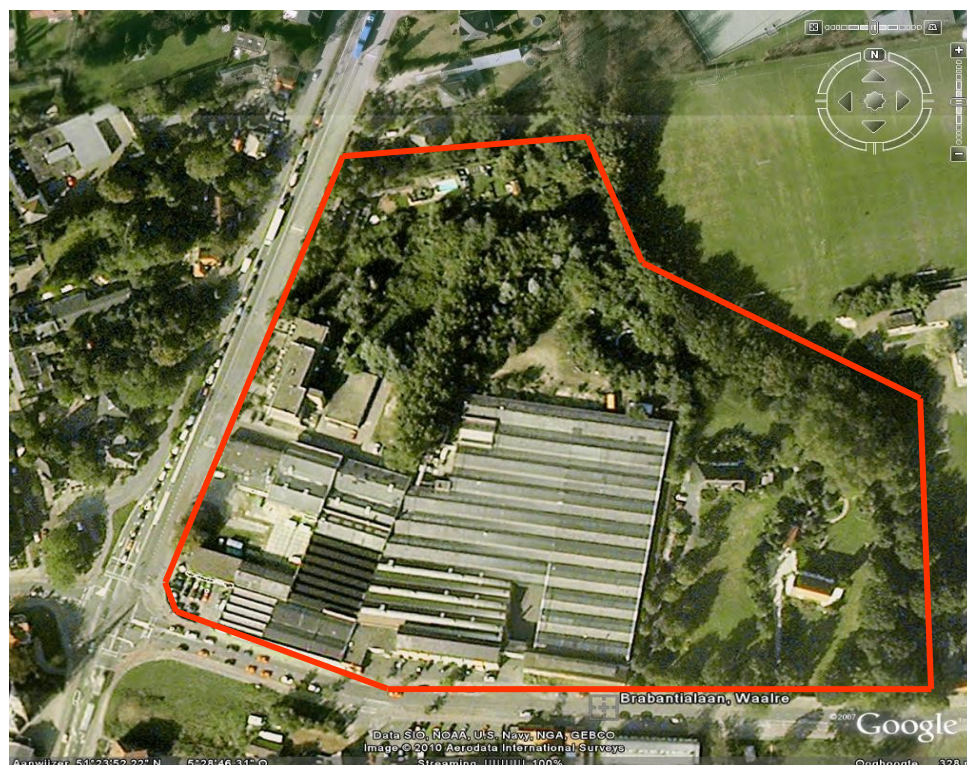
Figuur 2: Gebruikssituatie vóór sloop
